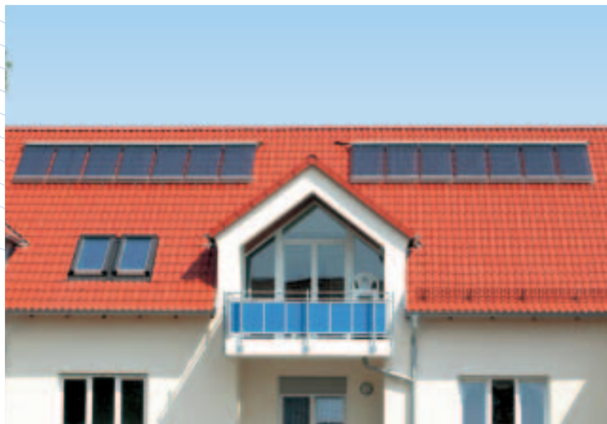
14 capteurs solaires suffisent pour réchauffer l'eau sanitaire d'une résidence.
