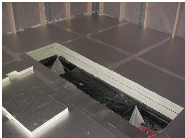
Photographie 4 : Isolation par le sol et passage des câbles
