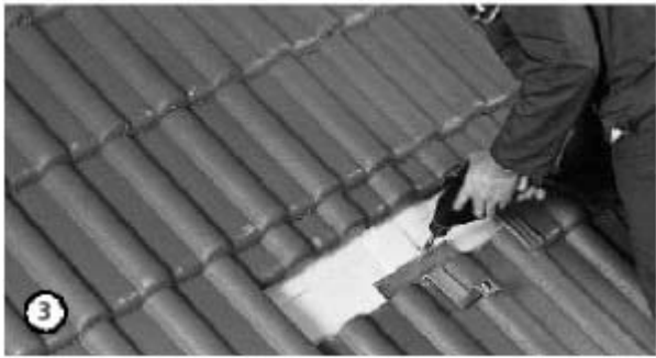
Figure - 7 mise en place des crochets chevron et du profilé support des capteurs
