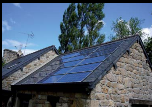
Photon Plus - Cédric Le Quellenec Orvault (44) - Pays-de-la-Loire Surface des capteurs : 15 m 2 - Puissance : 1,95 kWc
