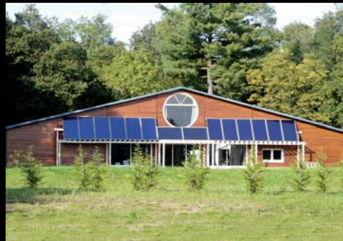
Sotram - Yves Mesnier Poligny (39) - Franche-Comté Système solaire combiné - Surface des capteurs : 35 m 2 Surface habitable : 500 m 2
