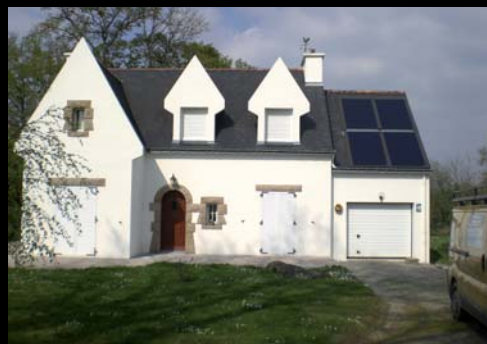
SARL Sanithermi - Catherine Perrigaud Baden (56) - Bretagne Système solaire combiné - Surface des capteurs : 11 m 2 Surface habitable : 126 m 2
