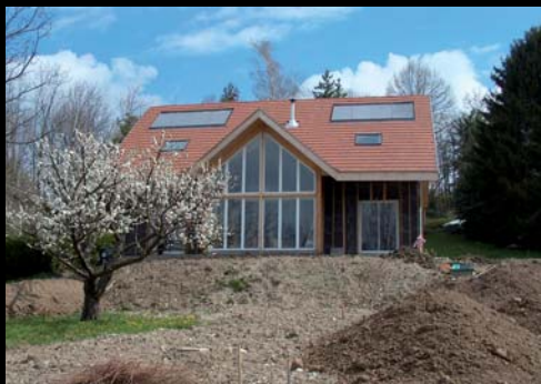
Bio&nergie - Laurent Courtiade Vaulnaveys-le-Haut (38) - Rhône-Alpes Système solaire combiné - Surface des capteurs : 16 m 2 Surface habitable : 160 m 2
