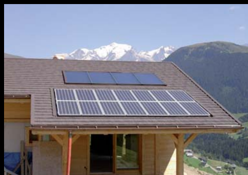
SARL Meilleur - Nicolas Meilleur Villard sur Doron (73) - Rhône-Alpes Surface des capteurs thermiques : 9,2 m 2 Surface des capteurs PV : 13 m 2 - Puissance : 2,5 kWc
