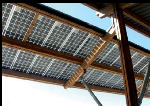
Entreprise Boissel Éric - Éric Boissel Saint-Sauveur (05) - PACA Surface des capteurs : 29 m 2 - Puissance : 3,2 kWc
