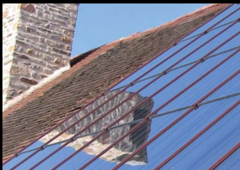
Entreprise Segard Philippe - Philippe Segard Condat-sur-Vienne (87) - Limousin Système solaire combiné - Surface des capteurs : 24 m 2 Surface habitable : 200 m 2
