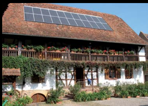
Greiner électricité - Franck Greiner Pfaffenhoffen (67) - Alsace Surface des capteurs : 38 m 2 - Puissance : 5 kWc
