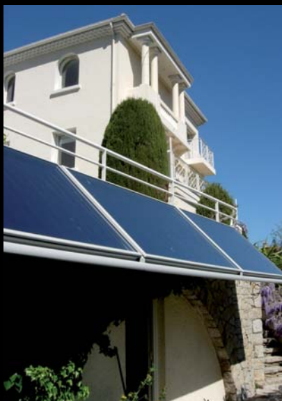
Terrasource - Andreas Semmel Aubagne (13) - PACA Chauffe-eau solaire individuel Surface des capteurs : 7,5 m 2 - Bénéficiaires : 7 personnes
