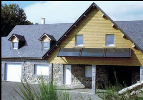
SARL Perugneau - Lionel Perugneau Perpezat (63) - Auvergne Chauffe-eau solaire individuel - Surface des capteurs : 6 m 2 Bénéficiaires : 4 personnes
