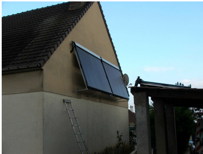
Inclinaison 72^\circ par rapport à l'horizontale (position hiver).
