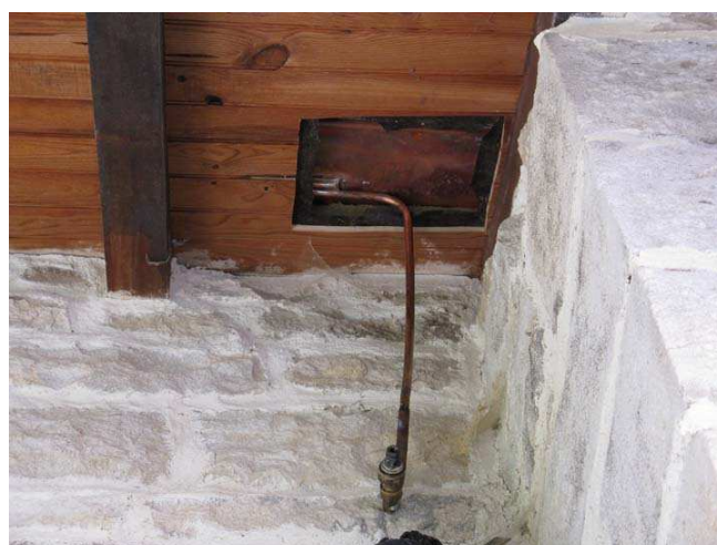
Une bonne trappe de visite : accès facile à la sonde de température.
