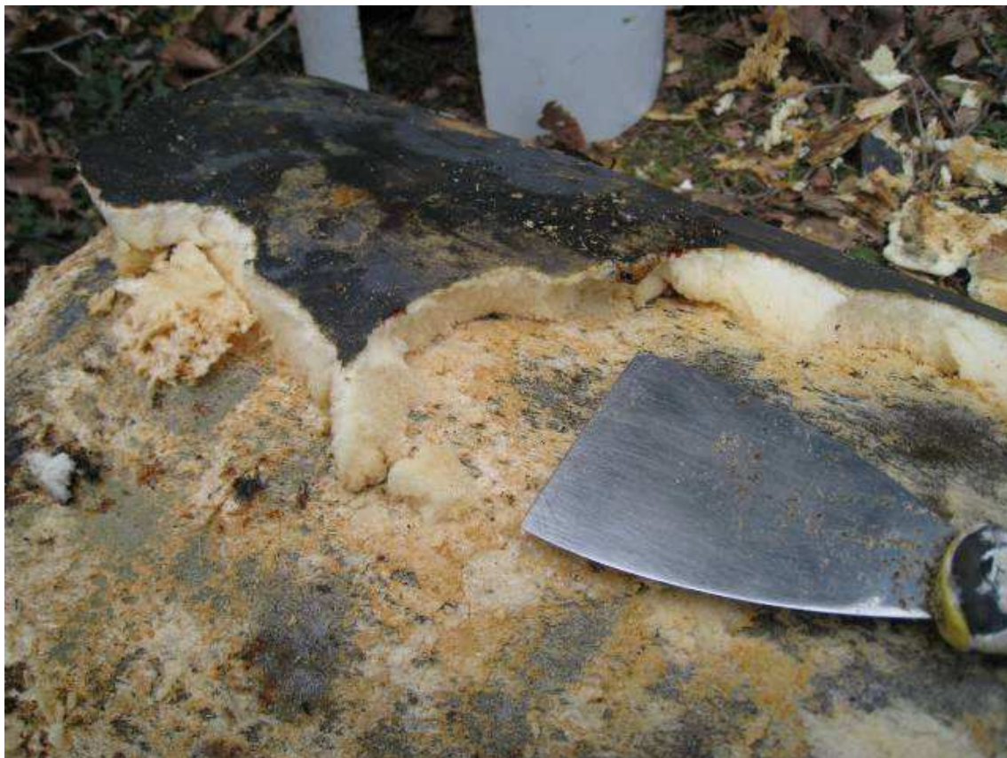
Suppression de l'isolation en mousse du ballon (suite)
