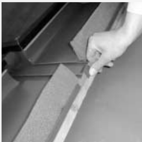
Figure 7.5.12 : Renversement de l'extrémité supérieure du listel de couverture sur les parties supérieures
