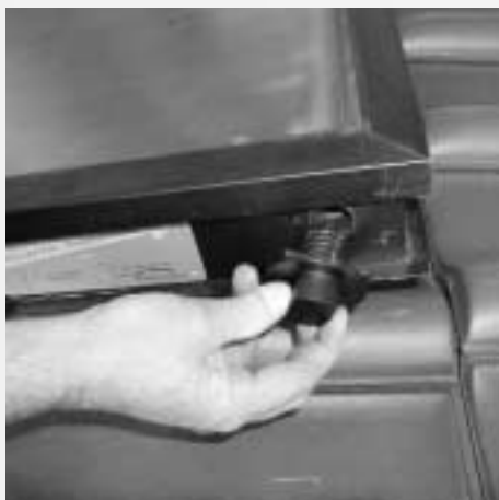
Figure 7.3.7 : Mettre en place le bouchon de fermeture de capteur vers le haut avec le côté baïonnette aplati (bouchon d'étanchéité lubrifié !)...
