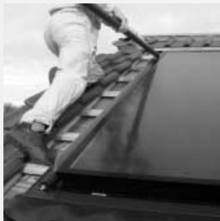
Figure 7.2.11 : Fixer le tuyau de raccordement d'arrivée perpendiculairement à la surface du capteur (bouchon d'étanchéité lubrifié), enfoncer et basculer vers le bas de 90°
