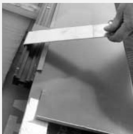
Figure 7.2.1 : Accrochage du crochet de fixation de capteur dans le rail profilé de montage
