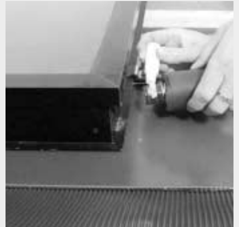
Figure 7.3.1 : Lubrification du bouchon d'étanchéité du raccord de retour avec le lubrifiant fourni à la livraison
