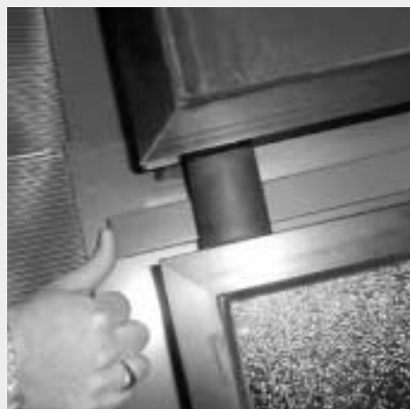
Figure 7.5.11 : L'extrémité inférieure repliée du listel de couverture prend sous les tôles de gouttière en U
