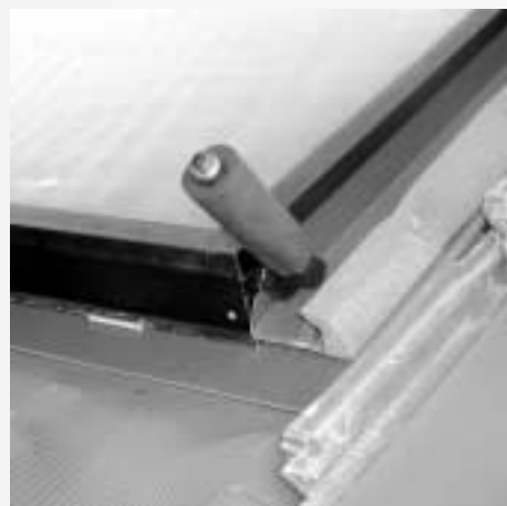
Figure 7.5.17 : Montage du bouchon de fermeture et des tuyaux de raccordement de capteur en position correcte
