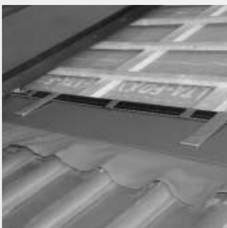
Figure 7.3.5 : Préparations d'appui de collecteur fermé
