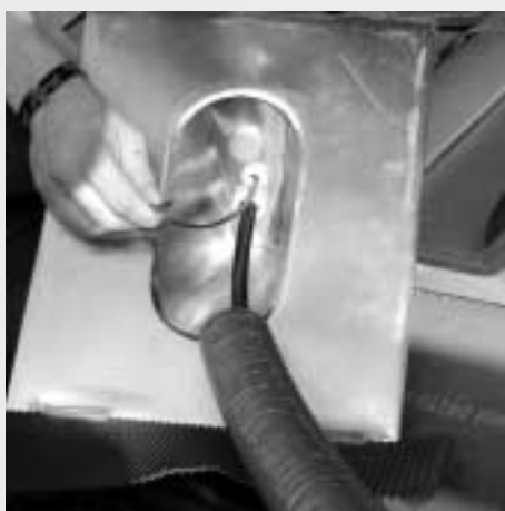
Figure 7.6.4 : Tirer le câble de la sonde capteur de l'extérieur vers l'intérieur
