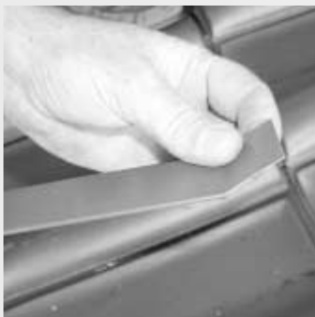
Figure 7.5.8 : Relèvement de la bordure supérieure du listel de couverture
