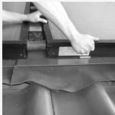
Figure 7.3.10 : Rapprocher soigneusement les capteurs
