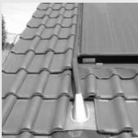
Figure 7.6.15 : Montage définitif des conduits de raccordement de capteur
