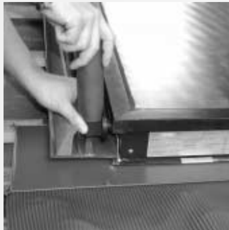
Figure 7.2.10 : Fixer le tuyau de raccordement de retour perpendiculairement à la surface du capteur, enfoncer et basculer vers le bas de 90°
