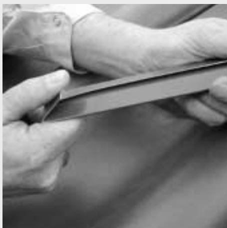
Figure 7.5.7 : Pliage de la bordure inférieure du listel de couverture
