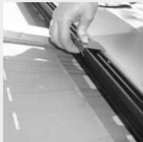
Figure 7.1.12 : Compression de la tôle de blocage de fixation dans la rainure latérale du profilé de montage.
