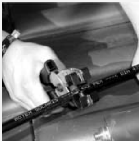
Figure 7.6.9 : Tuyau de retour en plastique (ø 16 x 2) raccourci à la longueur adaptée
