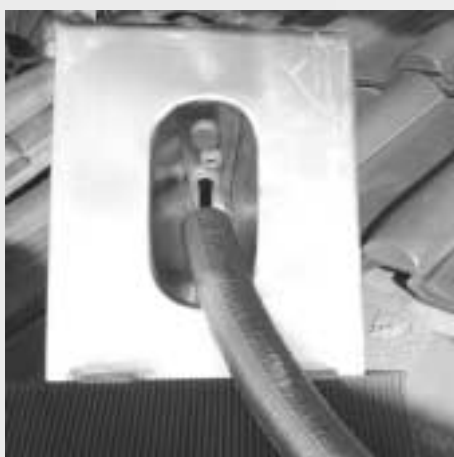
Figure 7.6.3 : Insérer la conduite de départ en matière synthétique
