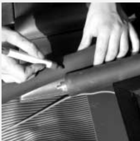
Figure 7.6.10 : Déterminer et couper la longueur nécessaire du flexible d'isolation thermique
