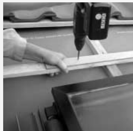
Figure 7.5.4 : Pose du listel auxiliaire pour raccordement aligné des tôles de couverture
