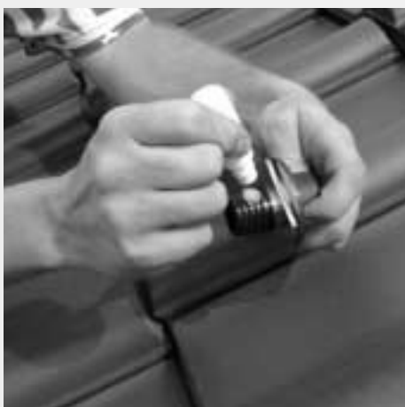
Figure 7.3.6 : Lubrification du bouchon d'étanchéité du bouchon de fermeture de capteur avec le lubrifiant fourni à la livraison
