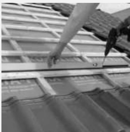
Figure 7.1.7 : Orientation et calage si nécessaire du rail profilé de montage.
