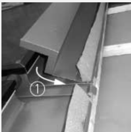
Figure 7.5.14 : Pousser le capot de couverture sous l'appui de tuiles
