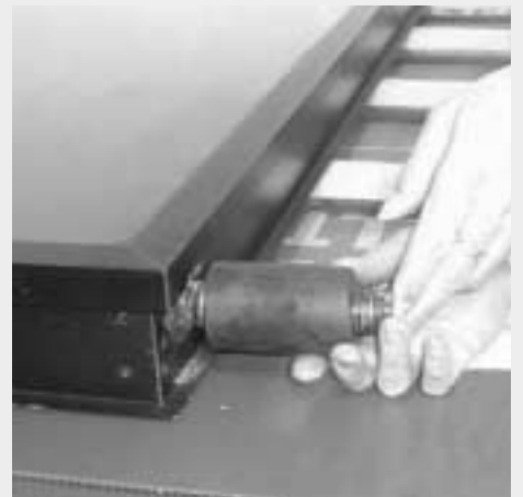
Figure 7.3.2 : Introduction de l'élément de raccordement de capteur en butée dans le collecteur
