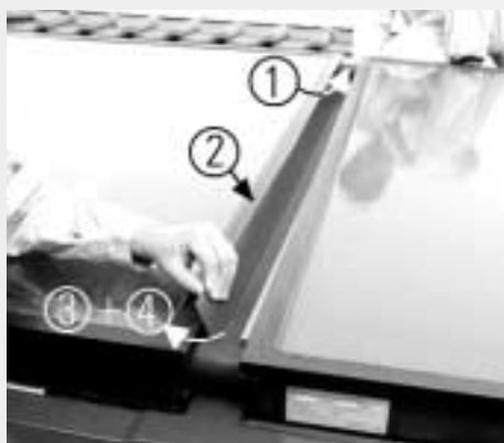
Figure 7.5.1 : Pose de la tôle de gouttière en U en deux parties à gauche (pour le côté gauche du capteur)
