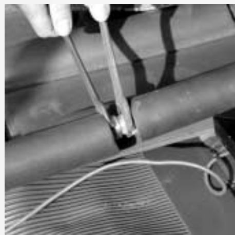
Figure 7.6.13 : Serrage du raccord à vis à bague de blocage
