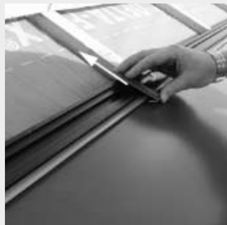
Figure 7.1.11 : Accrochage de la tôle de blocage dans le joint.
