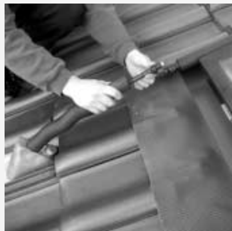
Figure 7.6.11 : Pousser et comprimer le flexible d'isolation thermique, placer l'écrou à chapeau et la bague de blocage
