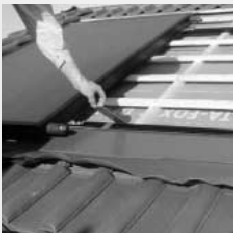
Figure 7.3.4 : Accrochage des crochets de fixation de capteur
