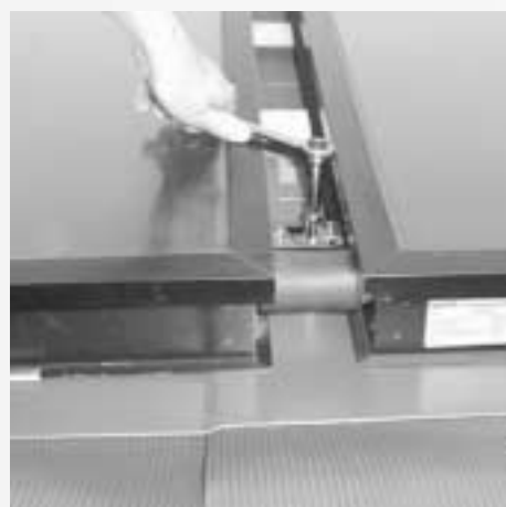
Figure 7.3.11 : Serrage des raccords de blocage à vis de capteur
