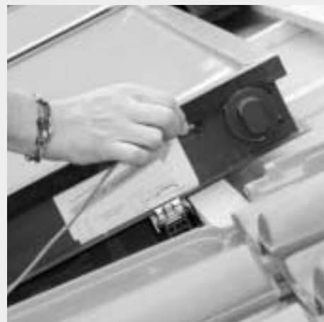
Figure 7.4.3 : Introduction de la sonde de température de capteur en butée dans le manchon immergé
