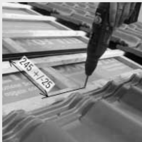
Figure 7.1.10 : Fixation des lattes auxiliaires pour soutenir le profilé de montage inférieur.
