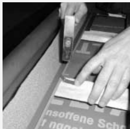
Figure 7.5.16 : Fixation des tôles de couverture latérales avec les pattes de fixation
