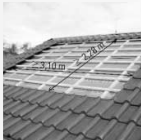
Figure 7.1.1 : Couverture de tuiles dans la zone des panneaux de capteurs
