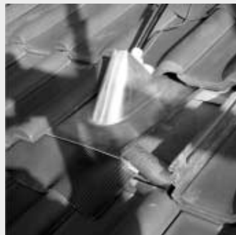
Figure 7.6.5 : Couverture de la collerette de passage de toit, appliquer des collerettes en plomb
