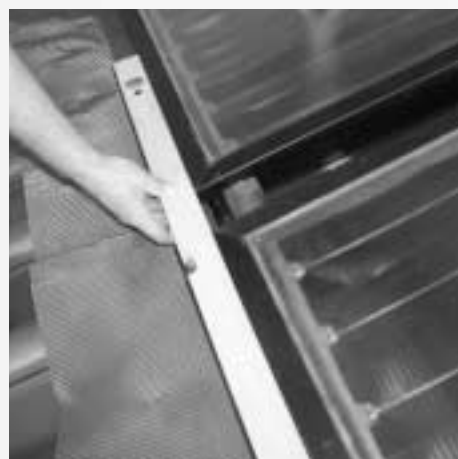
Figure 7.3.12 : Alignement des bords inférieurs de capteurs
