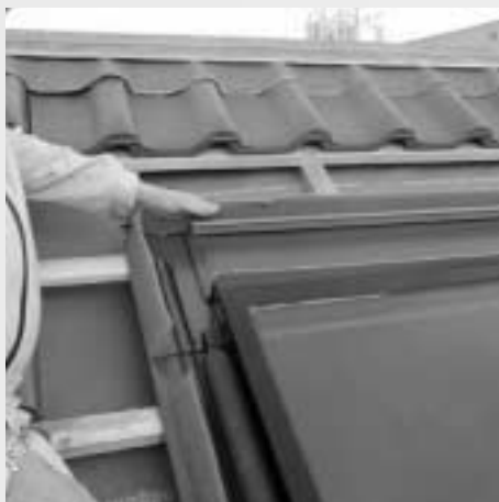
Figure 7.5.6 : Mise en place de la partie supérieure de cadre de couverture
