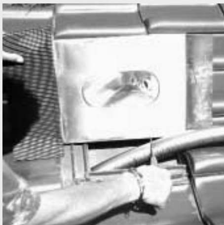
Figure 7.6.2 : Couper à la bonne longueur l'isolation thermique de la conduite de raccordement
