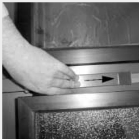
Figure 7.5.10 : Pousser le listel de couverture sur les tôles de gouttière en U
