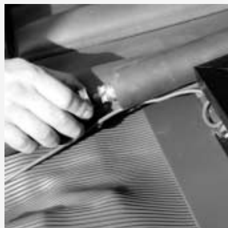
Figure 7.6.12 : Mise en place du tuyau PEX
