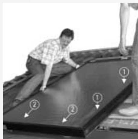
Figure 7.2.5 : Pose du capteur sur les profilés de montage, accrochage dans les crochets de fixation et orientation par déplacement latéral
