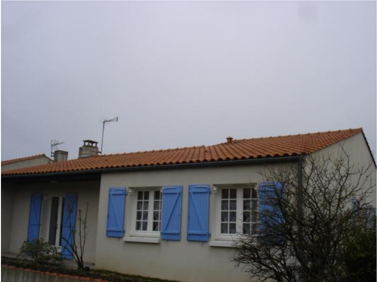
Côté rue facade est
