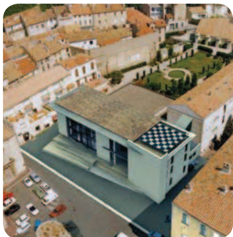
Toiture photovoltaïque en damier sur la MJC de Narbonne - architecte : atelier 2Ai - Yvan Tognella architecte.
