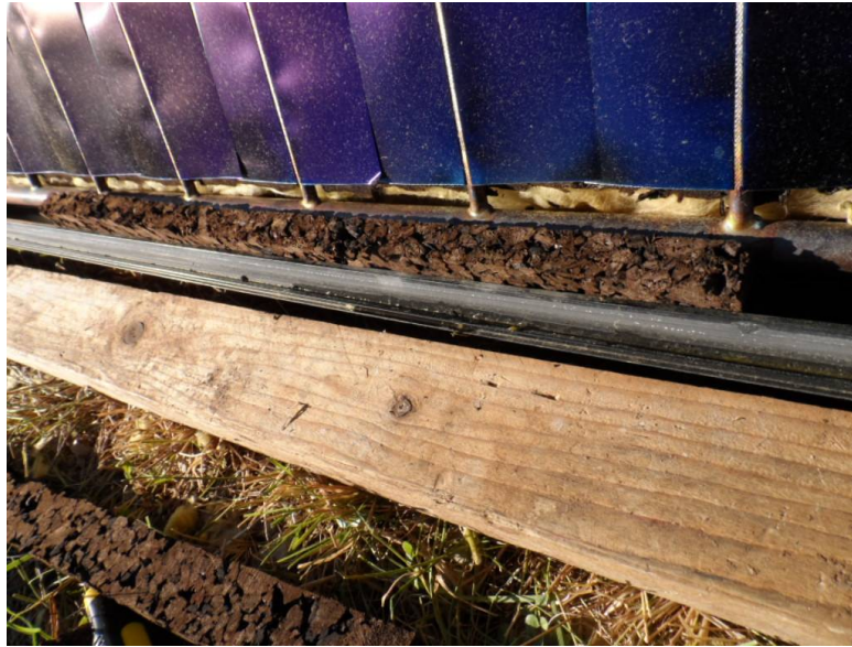
Début de la mise en place des bandes de liège.
