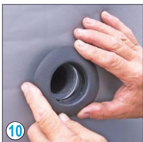
Manschette aufsetzen und eindrücken
