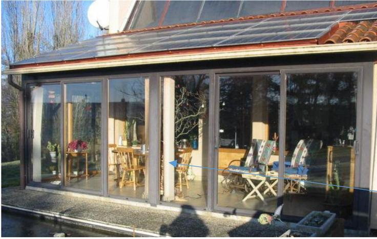
\* **La serre-véranda** est une véritable pièce à vivre. Elargie pour plus d'agrément et exposée plein sud, elle sert à la fois d'espace tampon entre l'intérieur et l'extérieur de la maison en période froide et de préchauffage ou de chauffage en fonction de l'ensoleillement hivernal. Pour la gestion de la surchauffe estivale, voir le principe ci-dessous.
