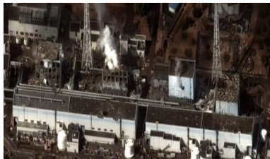
La centrale de Fukushima après le tsunami © Digital Globe
