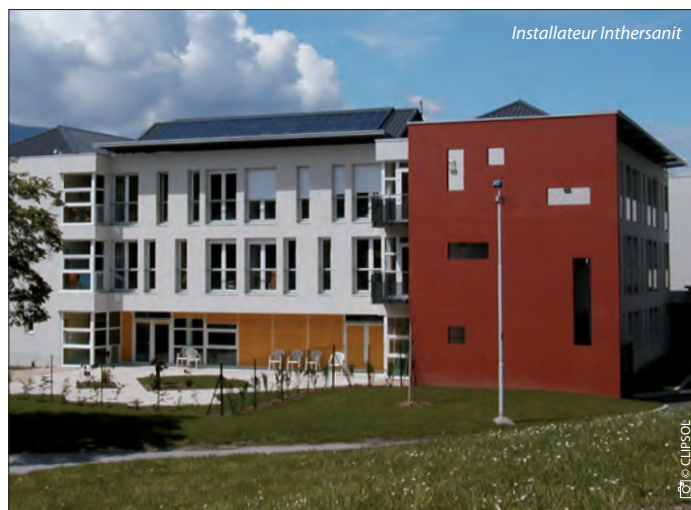
Les Berges de l'Hyères à Chambéry (Savoie-73) ; capteur TGD Th de 22 m 2
