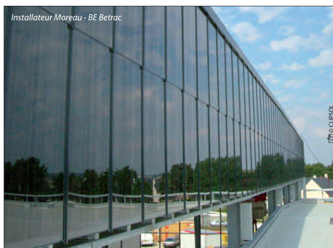
Complexe sportif du Souchais à Carquefou (44) - capteur TGD Th de 62 m 2
